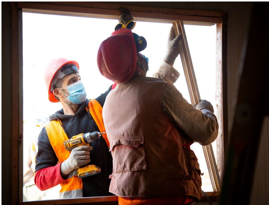
Des bénévoles bénéficiant d'une mesure incitative installent une fenêtre dans le cadre des réparations de la caravane de NRC dans le camp de Zaatari, en Jordanie. Photo : Tina Abu Hanna/NRC
